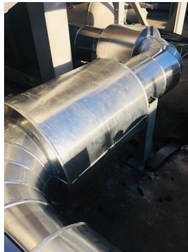
Foto 06: Instalação de proteção mecânica em alumínio liso
