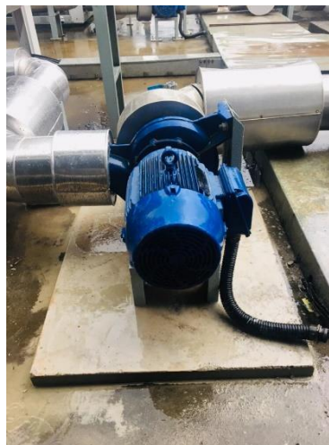
Foto 08: Grauteamento das bases da suporta o
