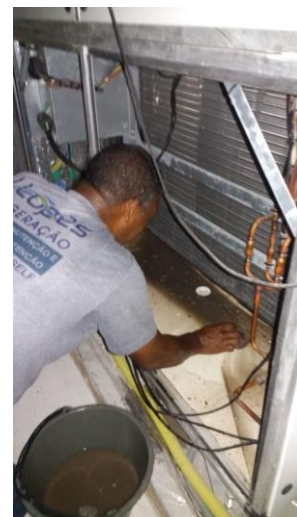
Foto 04: Limpeza de bandejas e desobstrução de drenos
