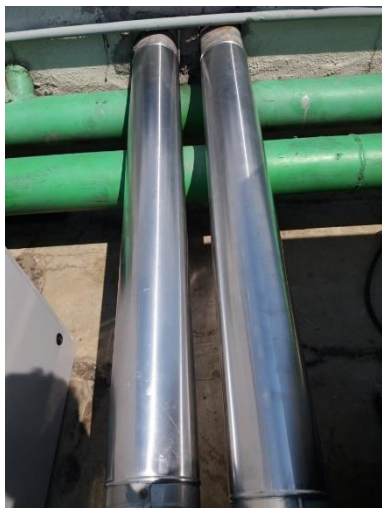
Foto 09: Substituição da proteção mecânica avariada da tubulação de água gelada.
