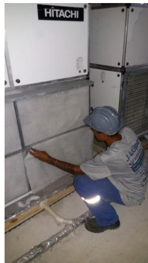
Foto 06: Substituição dos filtros de ar G3 dos equipamentos
