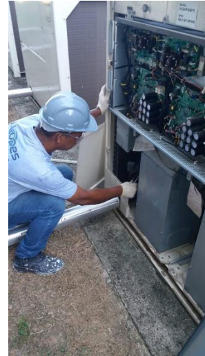
Foto 02: Verificação de componentes elétricos e internos dos condensadores
