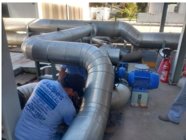
Foto 03: Alinhamento da tubulação e junta de expansão da saída da bomba
