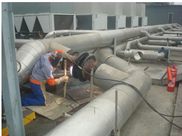
Foto 03: Soldagem dos flanges com eletrodo revestido na tubulação
