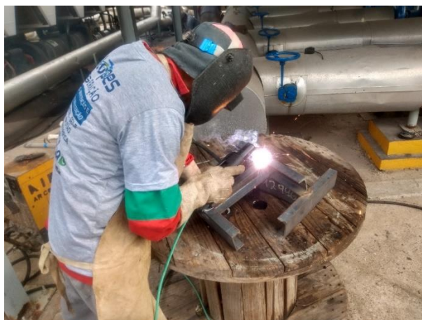
Foto 04: Processo de confecção dos suportes de tubulação
