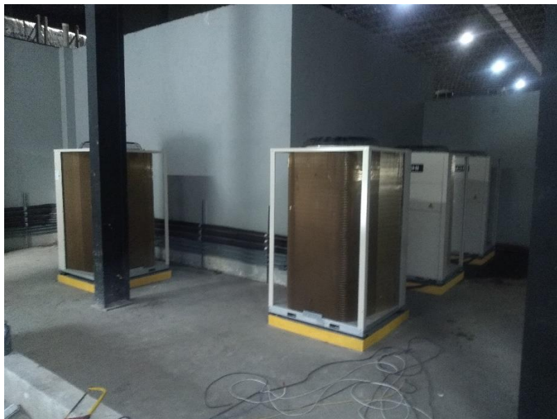
Conclusão da instalação das unidades condensadoras
