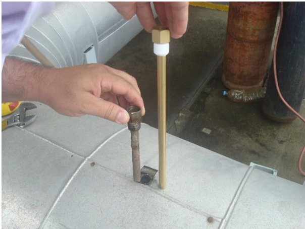
Foto 07: Substituição dos poços em latão para melhor precisão de aferição da temperatura
