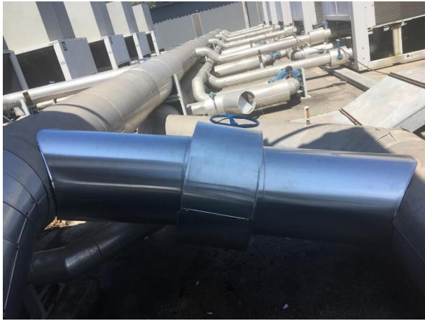
Foto 05: Instalação finalizada com isolamento térmico e proteção mecânica
