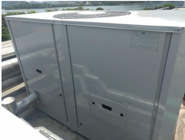
Foto 06: Chiller revisado, pintura anticorrosiva, substituição de parafusos inoxidáveis do chassi e pronto para startup .
