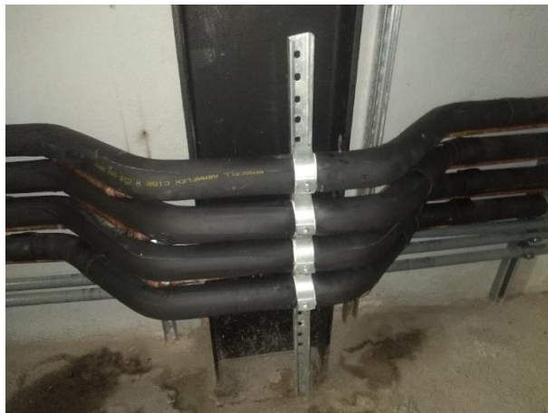
Foto 06: Isolamento térmico instalado e tubulação alinhada e ancorada
