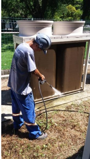
Foto 01: Lavagem de serpentina da unidade condensadora
