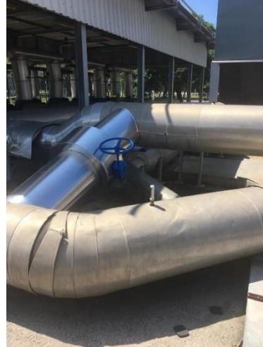
Foto 06: Instalação finalizada com isolamento térmico e proteção mecânica
