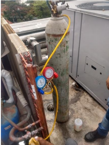
Foto 05: Pressurização do sistema com nitrogênio
