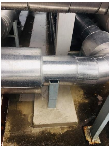
Foto 07: Posicionamento de nova suportaç o para a tubula o alinhada
