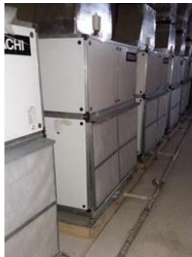
Foto 08: (Depois) Filtros de ar novos e limpos
