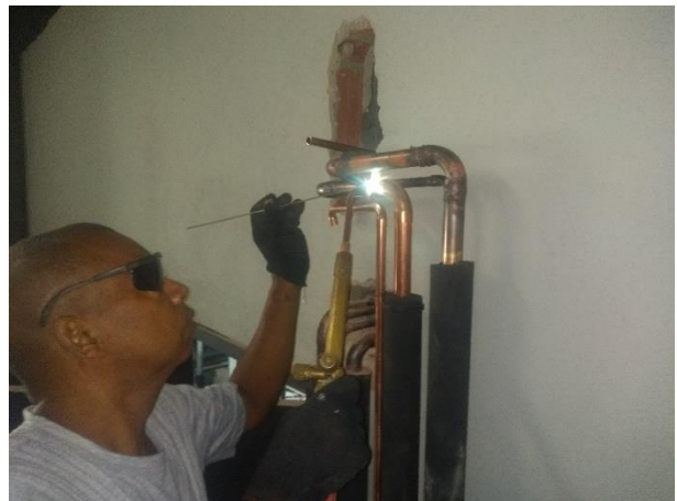
Foto 04: Soldagem da tubulação de cobre
