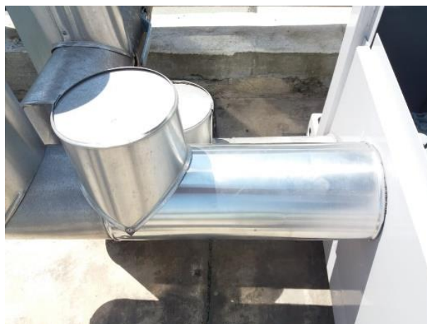
Foto 12: Substituição da proteção mecânica avariada da tubulação de água gelada.
