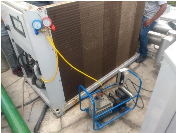
Foto 07: Desidratação e evacuação do sistema com bomba de alto vácuo
