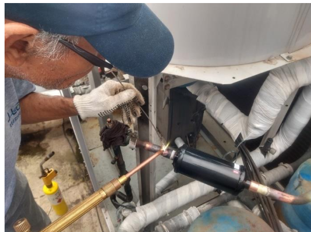
Foto 04: Processo de soldagem do novo filtro secador.
