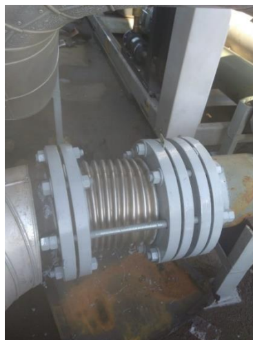
Foto 02: Junta de expansão substituída e tubulação alinhada
