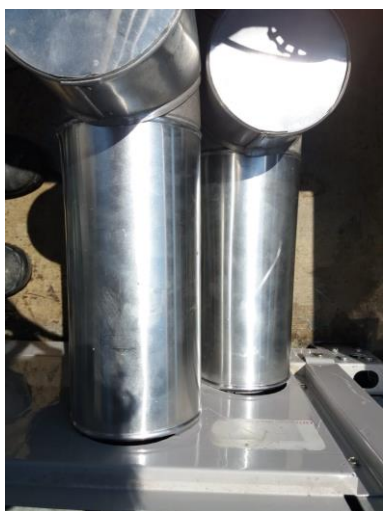
Foto 11: Substituição da proteção mecânica avariada da tubulação de água gelada.
