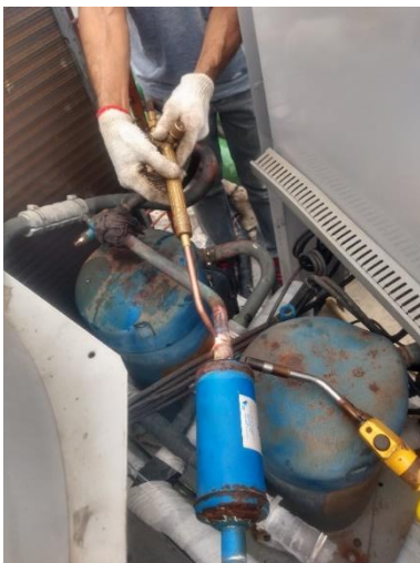
Foto 03: Remoção do filtro secador antigo
