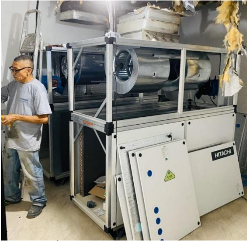
Foto 01: Instalação das unidades evaporadoras
