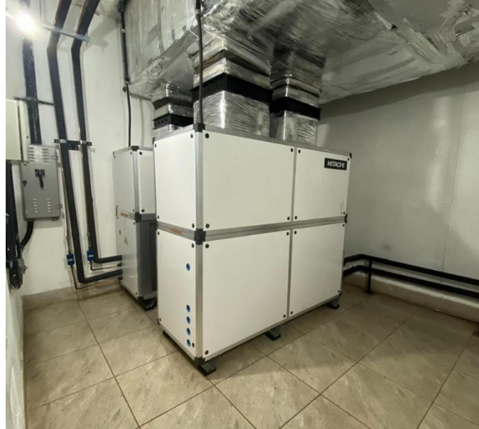
Conclusão da instalação das unidades evaporadoras
