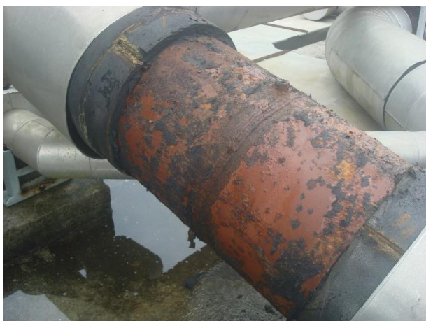
Foto 01: Remoção da proteção mecânica e isolamento térmico
