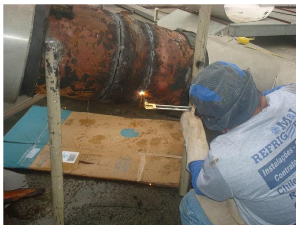
Foto 02: Oxicorte da tubulação para a instalação da válvula
