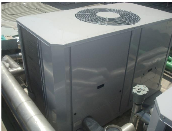
Foto 08: Motoventilador e componentes internos revisados e pintura anticorrosiva do chassi e componentes metálicos do chiller.
